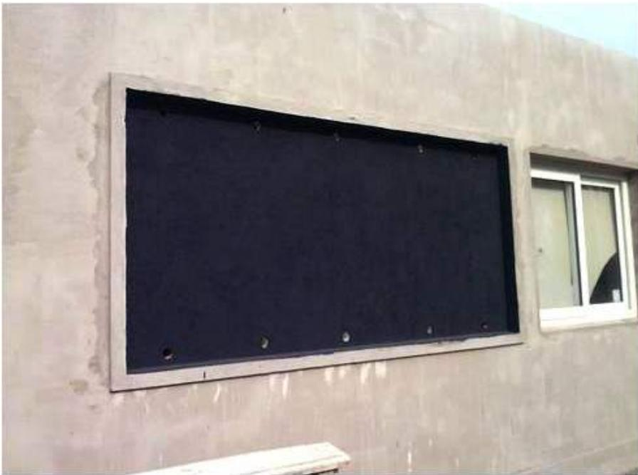
*Muro en construcción. En la foto anterior se puede observar la superficie de muro de ladrillo macizo, con revoque convencional y los orificios hechos con caños de PVC. En este caso, el resto de la construcción es de HCCA y adobe, ya que se decidió tener gran aislación térmica. En la foto de la izquierda, vemos que todavía no tenía el vidrio, pero que la superficie ya estaba pintada de negro.*
