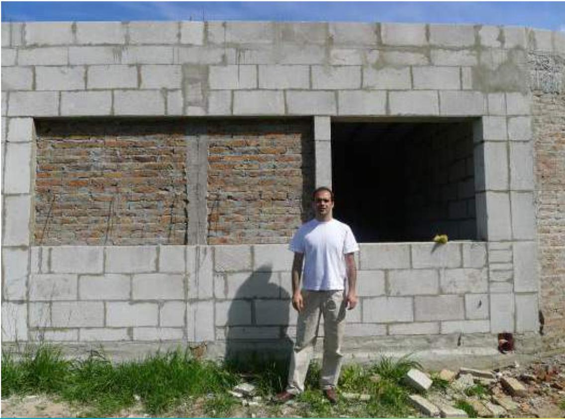
*Se observa el muro de ladrillo macizo, que luego sera el trombe. El resto de la construcción es de ladrillo HCCA y una parte de adobe. Coincidentemente, en la pared que corresponde al muro trombe, se ve una columna de hormigón (gris mas claro) que es la pared que divide las dos habitaciones.*
