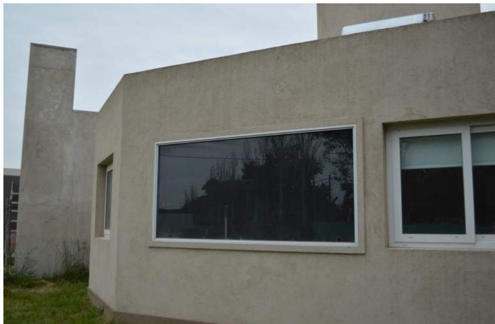
*El muro ya finalizado. Se observa el vidrio, la pared pintada de negro, y los orificios de caño de pvc, que comunican la cámara de aire con el interior de la vivienda, de donde se podrá elegir cuales será conveniente cerrar y cuales dejar abiertos.*
