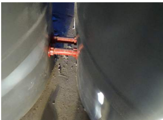
Unión entre los dos tanques para que se de el principio de vasos comunicantes
